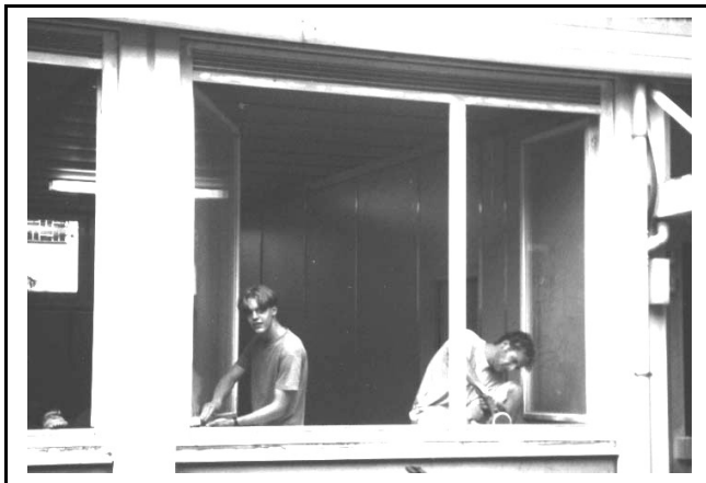
Die R/R beim Renovieren des Pavillons
